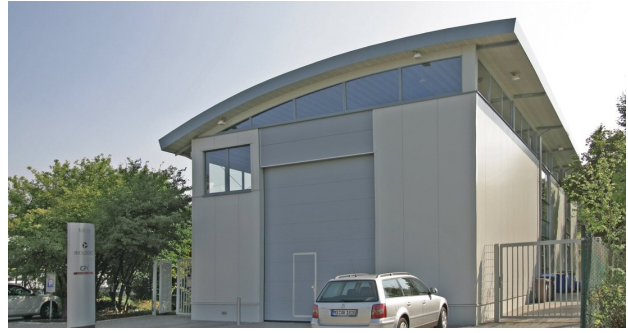
Sektionaltor 4,00 × 5,00 m mit integrierter Schlupftür
