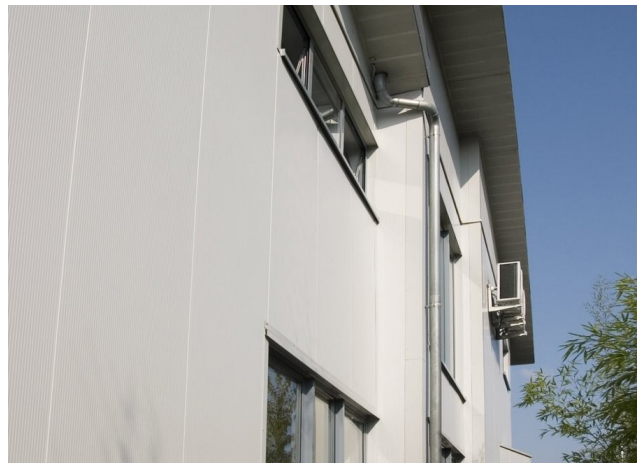
Fassade aus Iso-Sandwichpaneelen mit umlaufendem Fensterband
