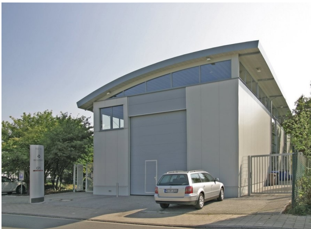
Sektionaltor 4,00 × 5,00 m mit integrierter Schlupftür
