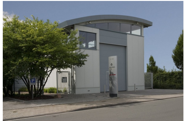
Gebäudefront zur Gildenstraße, Hallentor und Personenzugang
