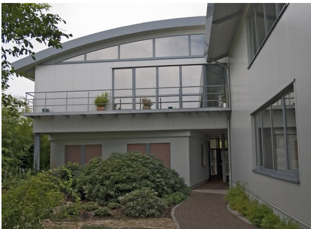
Balkon am Obergeschoss zum Innenhof
