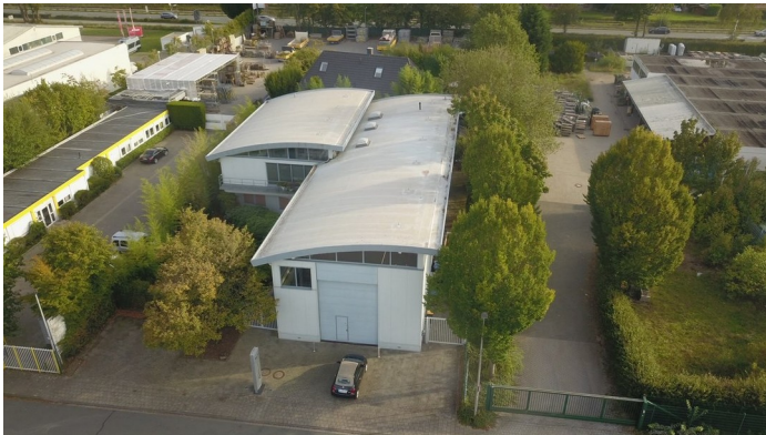
Luftbild des Objekts mit Zufahrt, Stellplätzen und Hallentor
