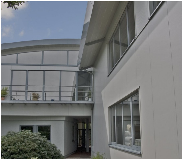
Innenhof mit Zuweg zum Haupteingang, Balkon und Oberlichtband
